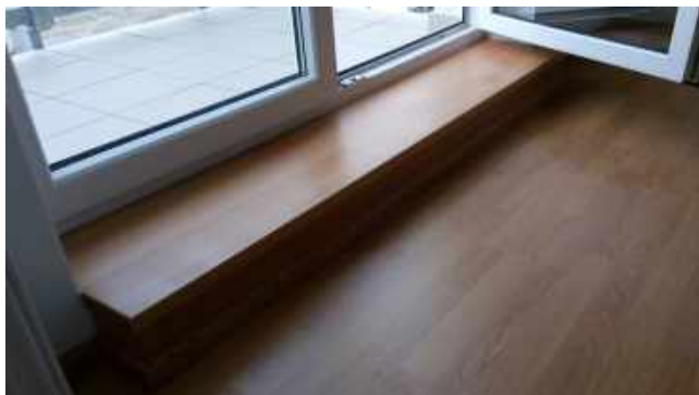
stupeň u dvoukřídlových balkonových dveří
